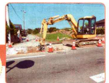
鉢形地区で液状化対策工事が 始まりました。
