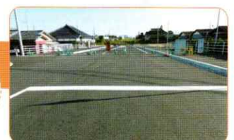
完成がめたる平井丘の整備中の道路。
